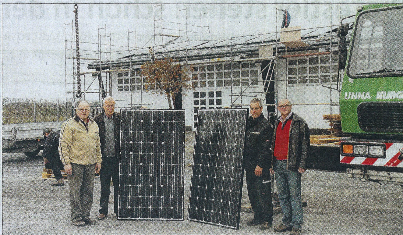
Die größte Investition in der Vereinsgeschichte. Die Schützen des Vereins Holzen-Bösperde-Landwehr nahmen ihre neue Photovoltaik-Anlage auf dem Dach ihrer Schützenhalle in Betrieb. WP-Foto: privat
